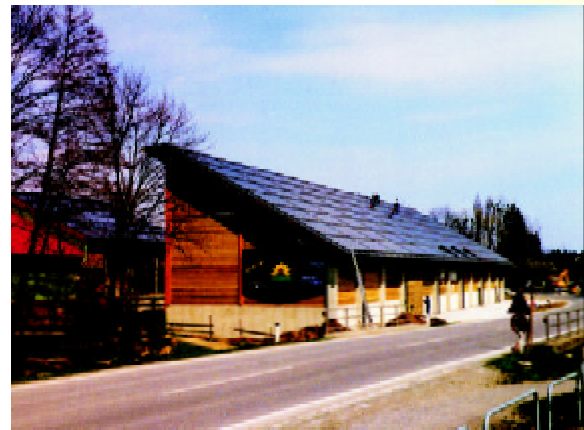
Nahwärme aus Biomasse und Sonne, Eibiswald
